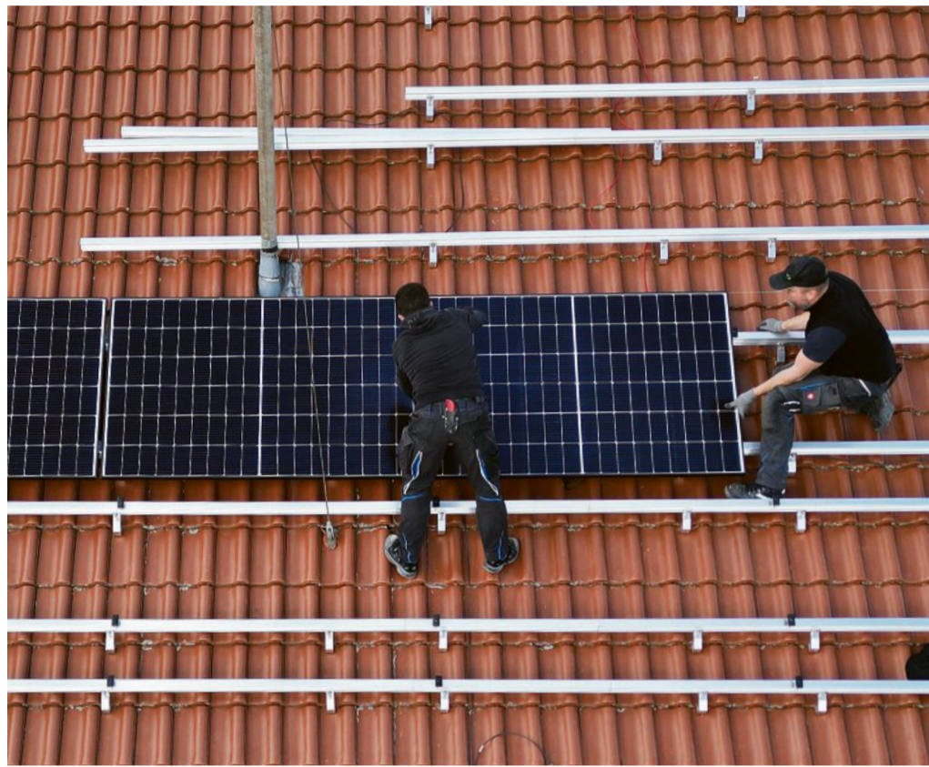
Photovoltaik-Anlagen sind ein Schwerpunkt der Firma Elektro Wagner aus Uhhingen. Nico Wagner leitet die Installation auf dem Dach, Dominik Wagner und seine Frau Vivian kümmern sich um Planung und Organisation. Foto: Elektro Wagner
